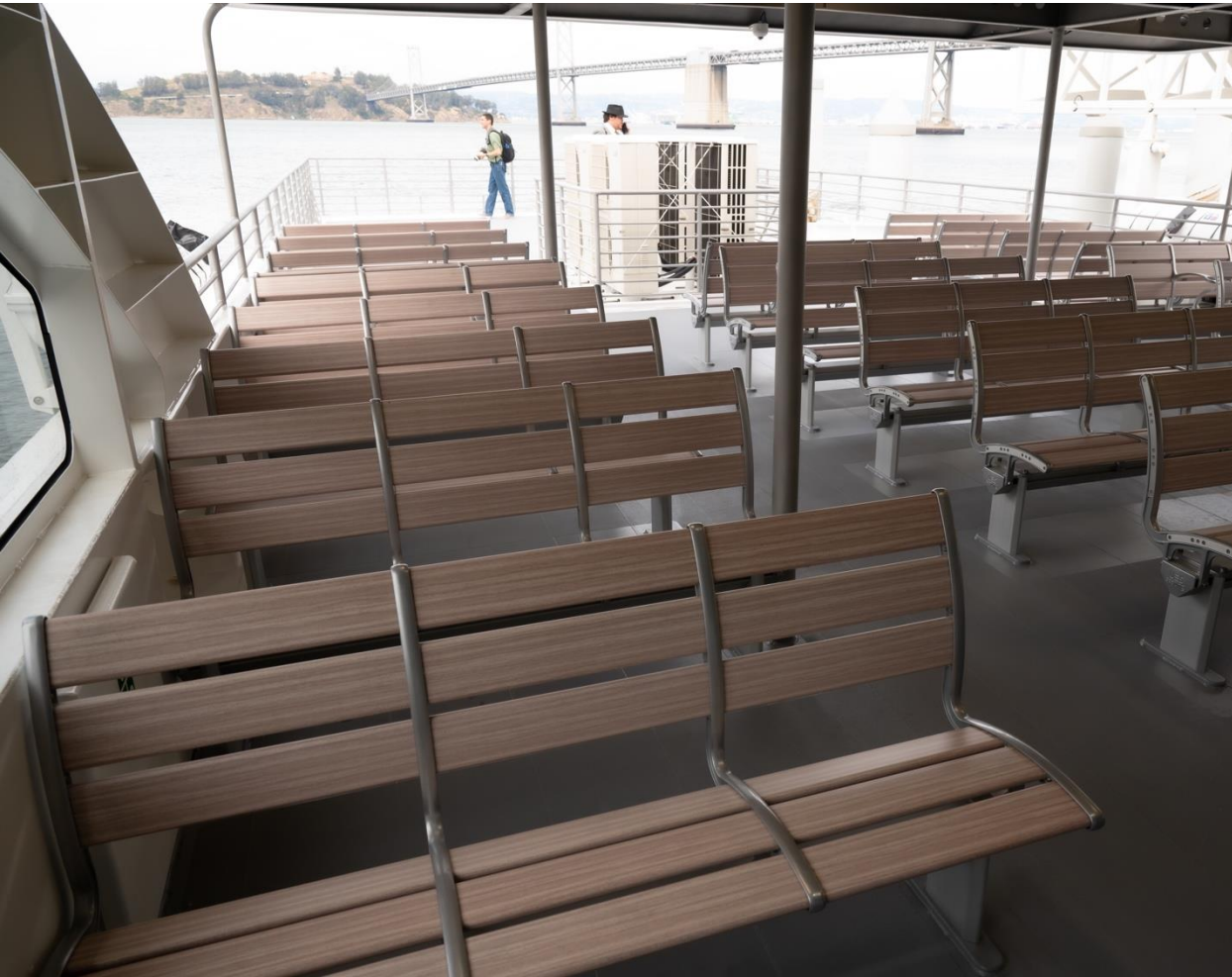
M.V. DORADO HVAC UPPER DECK
